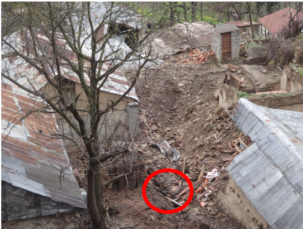
شکل-۲۲- از بین رفتن احشام ناشی از ریزش سنگ و تخریب کامل دامداری سنتی (دید به سمت جنوب باختر)
