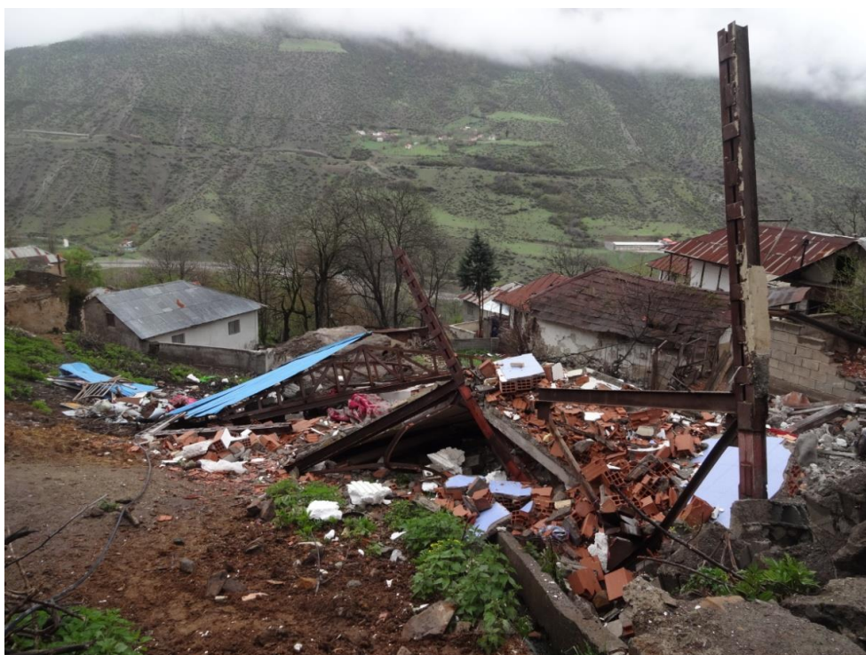
شکل-۲۳- تخریب کامل منازل مسکونی با اسکلت فلزی (دید به سمت جنوب باختر)
