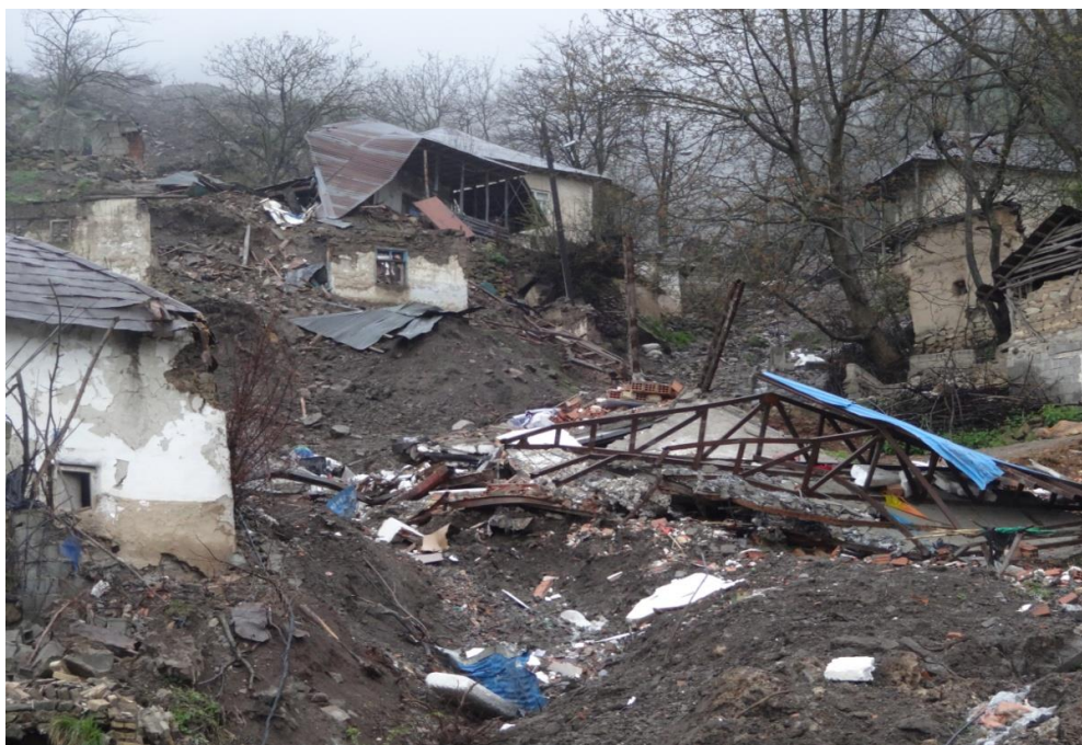
شکل-۲۴- تخریب کامل منازل مسکونی (دید به سمت خاور)
