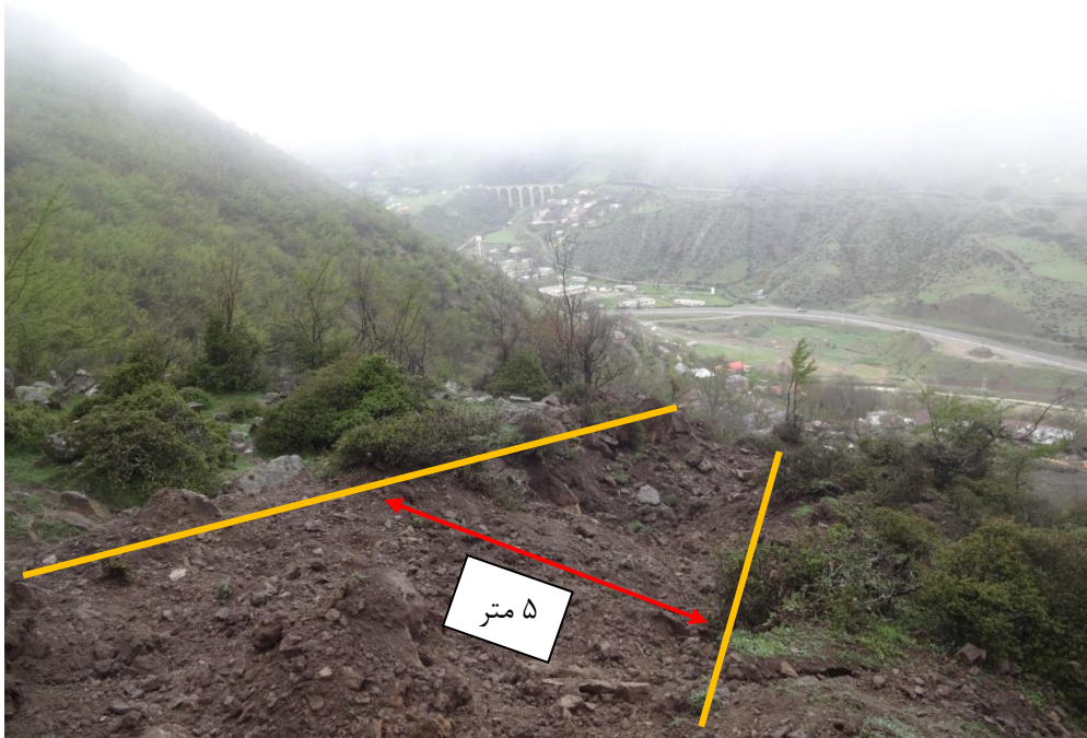
شکل-۲۱- کانال مسیر حرکت توده سنگ (دید به سمت جنوب باختر)
